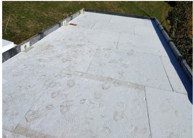
Einbau der Entwässerungs-Spider
