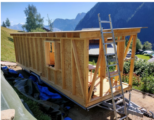
Beginn der Innenwandmontage
