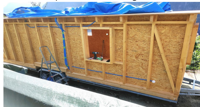
Leerrohre für die Elektroinstallation
