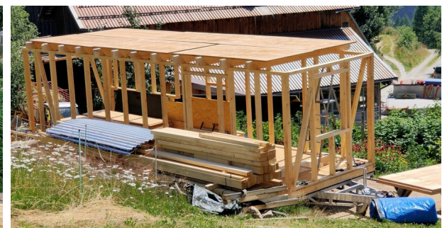
provisorisches Auflegen der Sperrholzplatten
