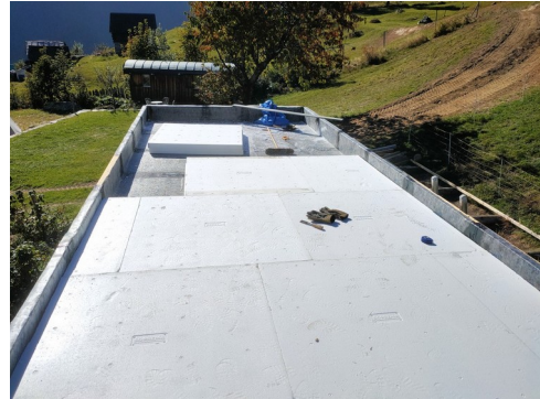
begehbare Dämmung beim Flachdach
