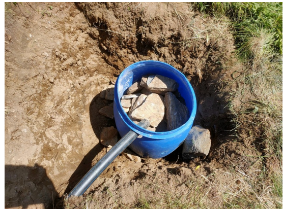
Versickerungsschacht
