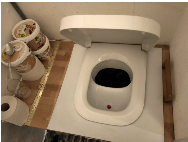
eingebaute Trenn-Toilette
