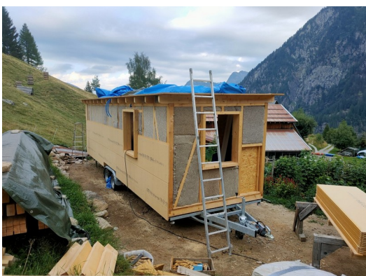
Dämmung der Wände mit Schafwolle und Gutex
