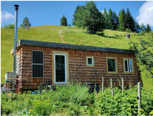
Fensterverkleidung ist montiert Frühjahr 2025
