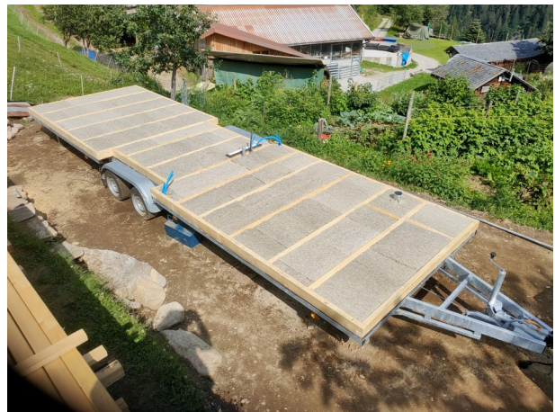
Schafwolldämmung im Fussbodenaufbau
