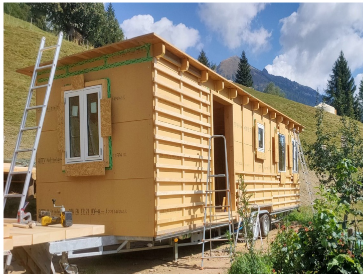
Beim Einbau der Fenster und der Lattung
