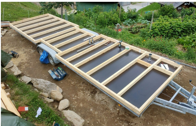
Bodenkonstruktion mit Durchführungen aber noch ohne Leerrohre und Dämmmaterial
