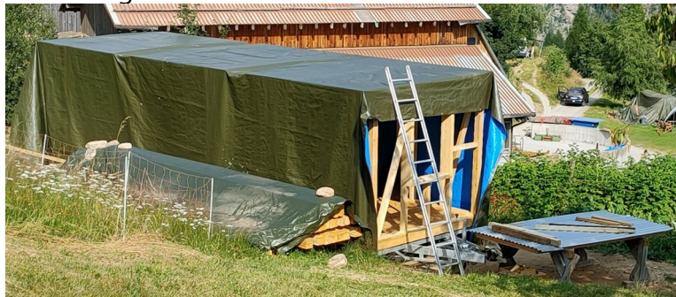
Wetterschutzplane über der Baustelle
