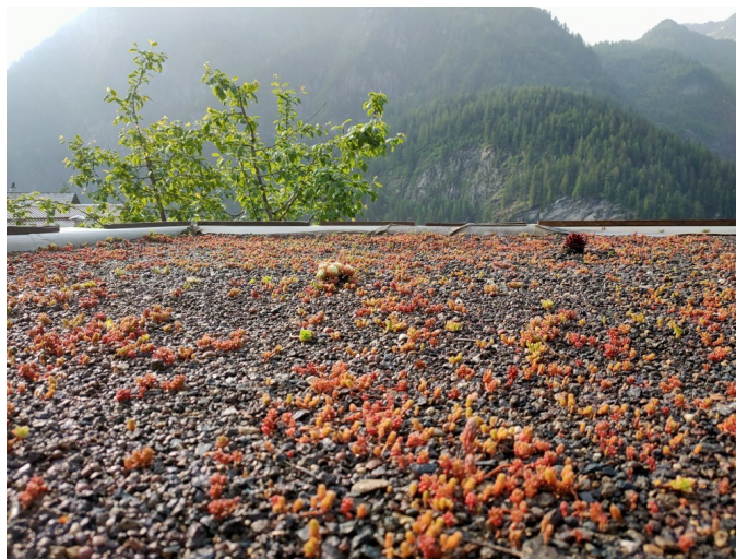
Juni 2025: Beginn der Dachbegrünung
