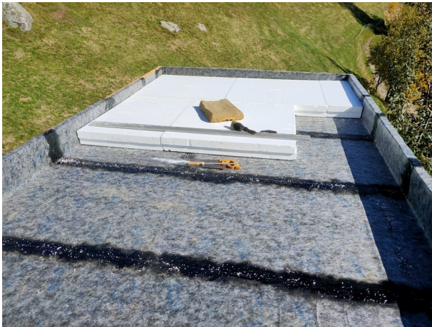
Schweissbahnen und begehbare Dämmung
