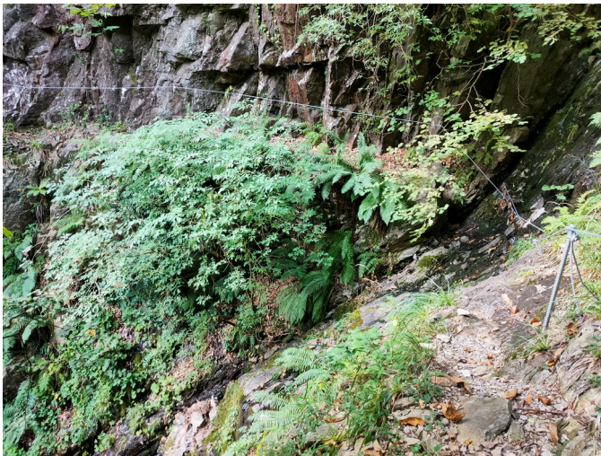
Stahlseilsicherungen am Berghang
