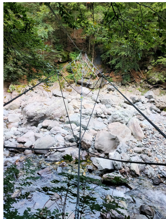
Hängebrücke als Stahlseilkonstruktion
