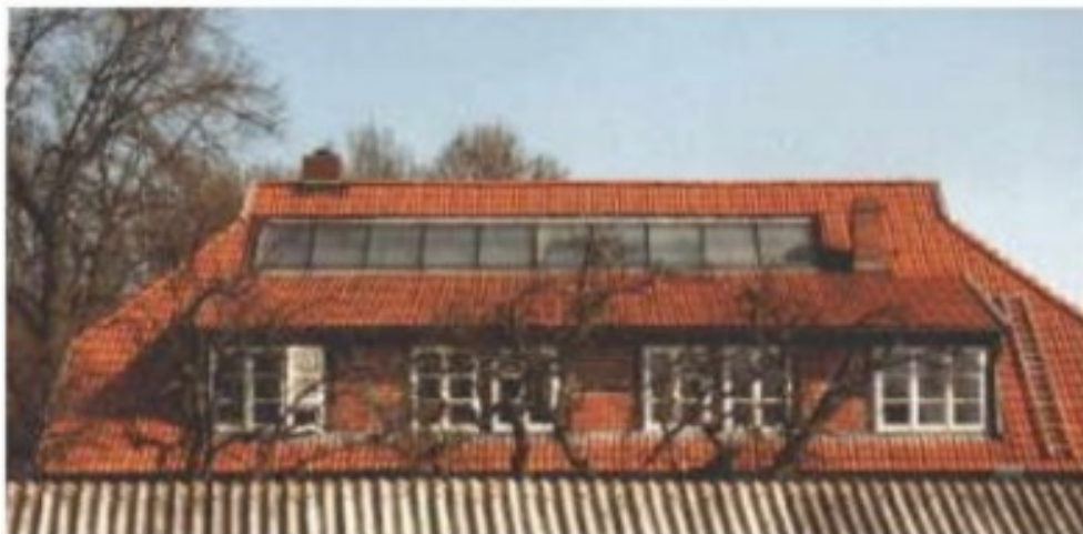
Kollektoren auf dem ausgebauten Dachboden in Karmitz
