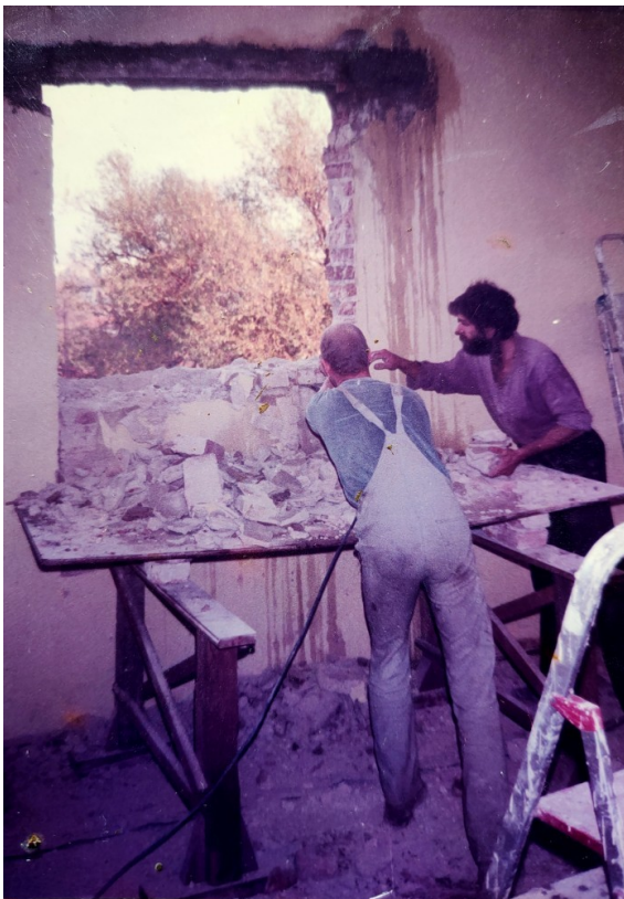
Vorarbeiten für Fenstereinbau im 3. Stock B 52
