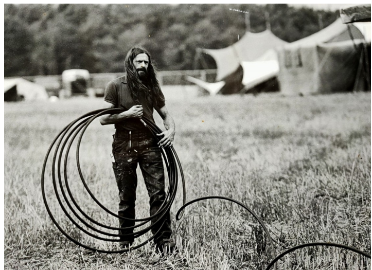
"Stay rude - Stay rebel" - beim Verlegen einer Wasserleitung
