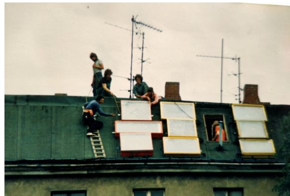
Dachmontage der Kollektoren B 52
