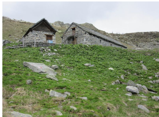
Abzweigstelle zum Lago Gelato und Lago dei Pozzöi
